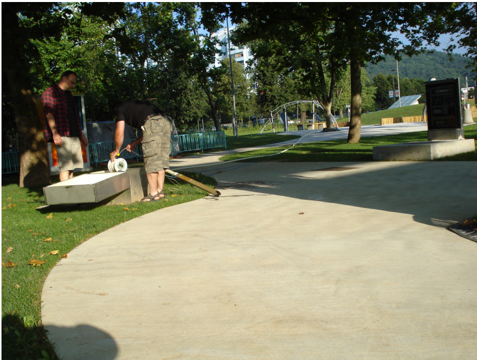
Slika 3: Vrtine in zunanja komunikacijska omarica na AMP Mercator na Ljubljanskem polju. Fotografija prikazuje kontrolo montaže črpalk (foto: Ladislav Podržaj).
