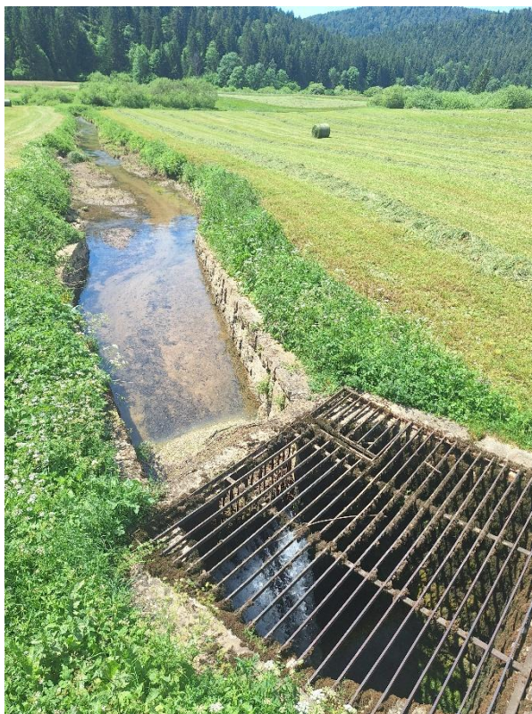
Slika 2. Požiralnik v dolini Loškega potoka; junij 2025; Foto: M. Horvat Figure 2. Sinkhole in Loški potok valley; June 2025; Photo: M. Horvat
